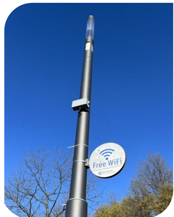
Lichtmast mit akustischer Sensoreinheit
