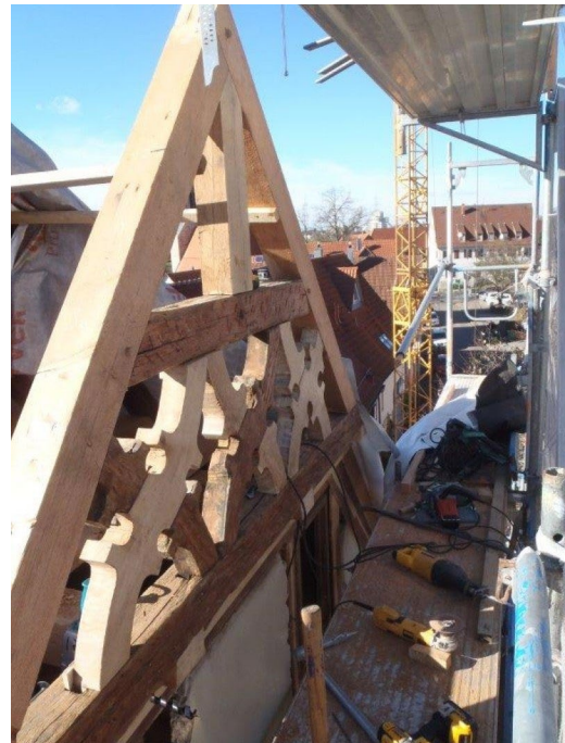
Abb. 2: Giebelwand eines Fachwerkhouses mit bereits sanierten Zierelementen [DHR Gleichberge GmbH]
