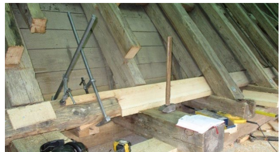
Abb. 1: Sanierung einer 5-kant-Schwelle [DHR Gleichberge GmbH]
